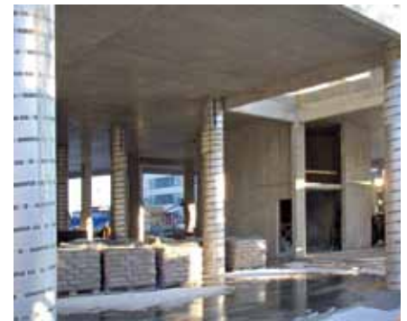
Obr. 9, 10 Stĺpy realizované s papierovým debnením
