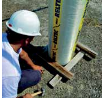
Obr. 7 Fixovanie debnenia dreveným krížom
